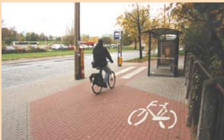
Droga rowerowa powinna biec z tyłu przystanku autobusowego, co zminimalizowałoby kolizje pieszych i rowerzystów
