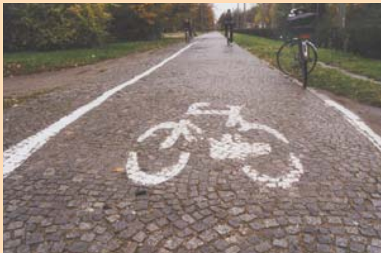
Wrocławską ciekawostką są fragmenty poniemieckich dróg rowerowych, budowanych z bardzo drobnej kostki kamiennej. Czyżby stąd brało się zamiłowanie wrocławskich projektantów do niewygodnej nawierzchni z kostki?
