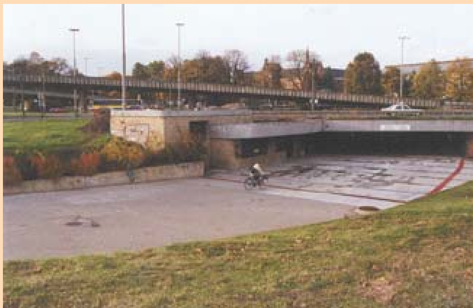
Tunel pod placem Zwycięstwa. Zwraca uwagę szeroki przekrój, wykorzystanie światła słonecznego oraz bezpieczne dla roweru, rozszerzające się ku górze ściany
