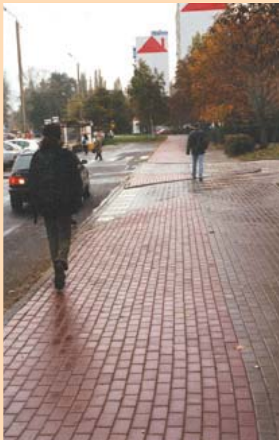
Nawierzchnia drogi rowerowej z kostki jest nieczytelna zarówno dla pieszych, jak i rowerzystów
